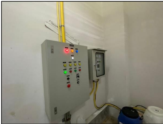
รูปที่ 3-66 ตู้คอนโทรลกระแสไฟฟ้าปั้มน้ำบาดาลตึก A และ ตึก B
