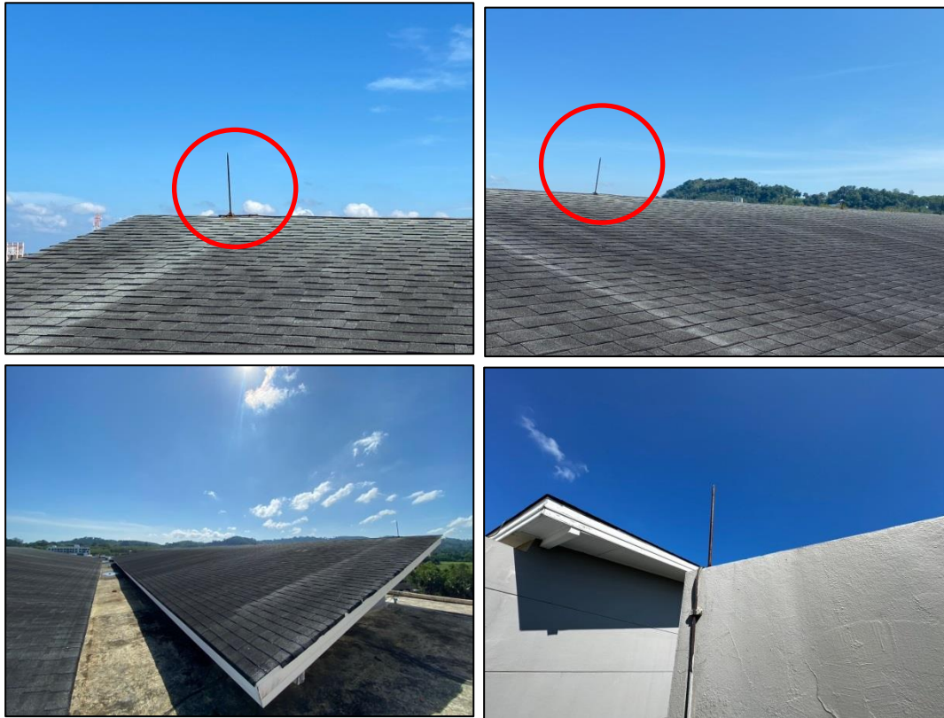
รูปที่ 3-58 ระบบป้องกันอันตรายจากฟ้าผ่า
