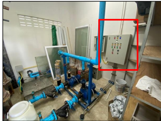
รูปที่ 3-66 ตู้คอนโทรลกระแสไฟฟ้าปั้มน้ำบาดาลตึก A และ ตึก B
