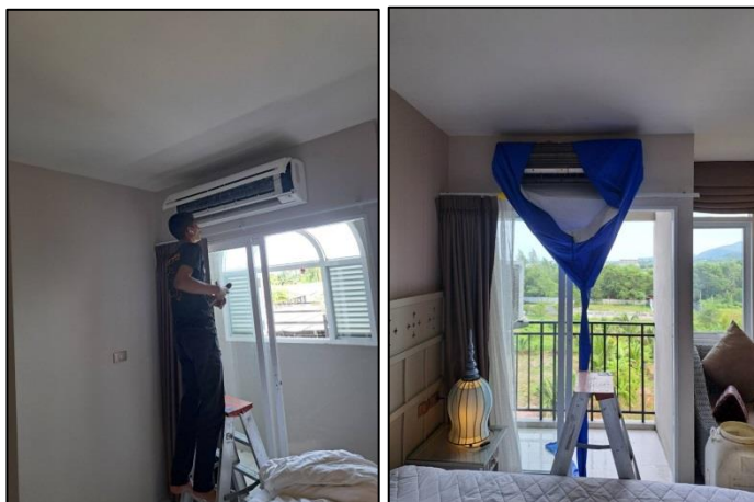
รูปที่ 3-59 เจ้าหน้าที่ทำความสะอาดและตรวจเช็คเครื่องปรับอากาศ
