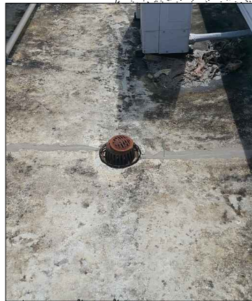
ตัวอย่างหัวรับน้ำบนหลังคาของอาคารโครงการ
